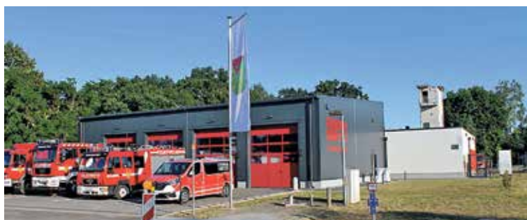
Der moderne Neubau mit der 330 Quadratmeter großen Halle, dem dahinterliegenden Sozialtrakt, in dem sich unter anderem ein Sport-, mehrere Lagerräume sowie Duschen, die Umkleide und eine Küche befinden.
