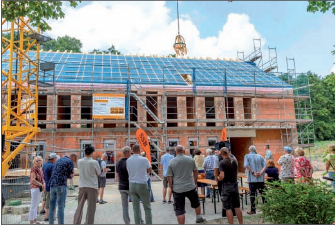
● Viele Besucher begleiteten das Richtfest fürs Haus Mühle am Mühlenteich in Eggersdorf. Foto: Edgar Nemschok
