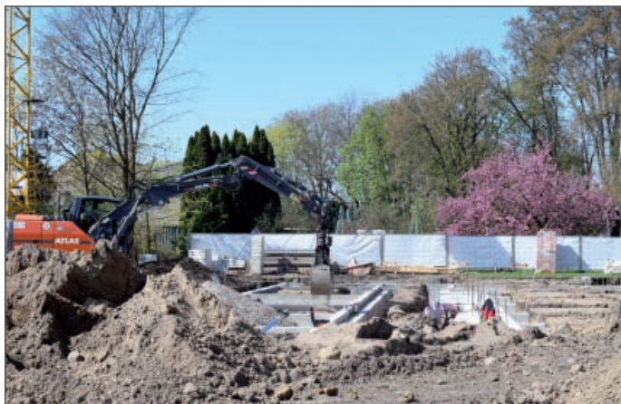
● Die Bauarbeiten am Haus Mühle in Eggersdorf schreiten gut voran. Hier eine Momentaufnahme vom 22.04.2026: Das Streifenfundament wird verfüllt. Foto: K. Brandau
