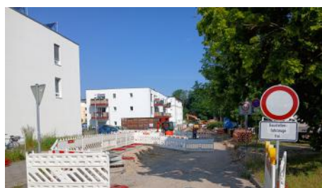
Dieser Bereich der Ringstraße ist wieder freigegeben.
